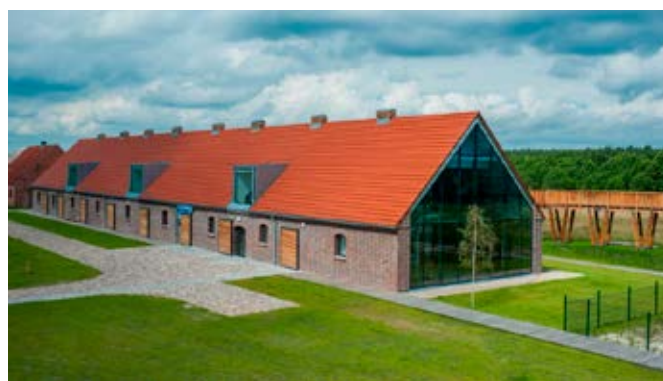
Fot. 15. Ukończenie budowy ośrodka edukacji ekologicznej w Zalesiu
