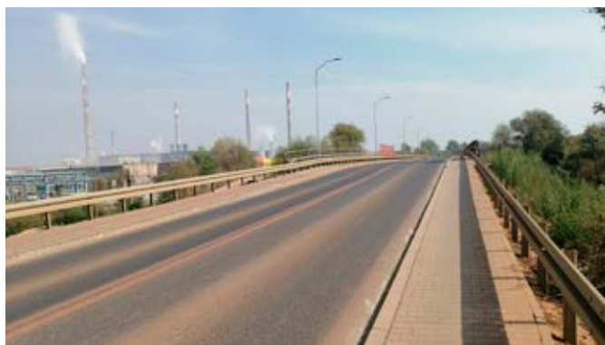
Fot. 10. Wiadukt drogowy w ciągu ulicy Kuźnickiej
