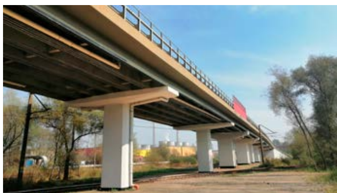
Fot. 11. Widok ukończonego wiaduktu z dołu
