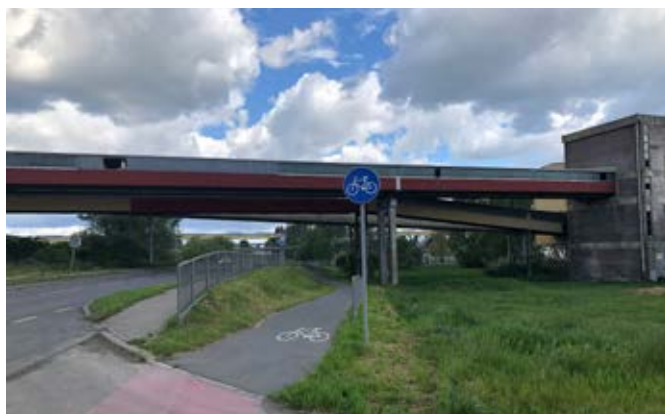
Fot. 3. Odcinek ścieżki rowerowej nieopodal zakładów Grupy Azoty
