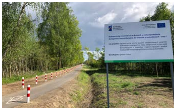
Fot. 2. Fragment nowo powstałej ścieżki rowerowej na odcinku Police–Trzebież
