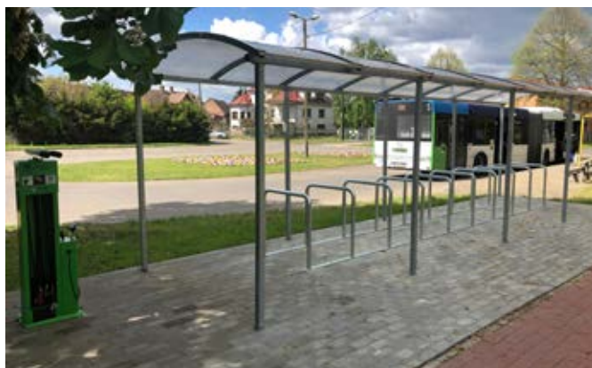
Fot. 1. Obiekt „Bike&amp;Ride” z urządzeniami do naprawy rowerów w Trzebieży
