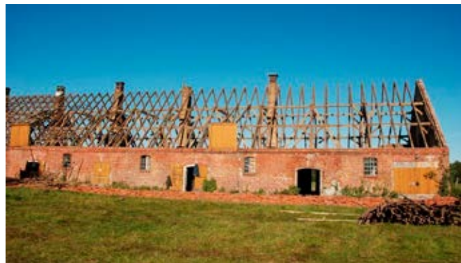
Fot. 14. Budowa ośrodka edukacji ekologicznej w Zalesiu
